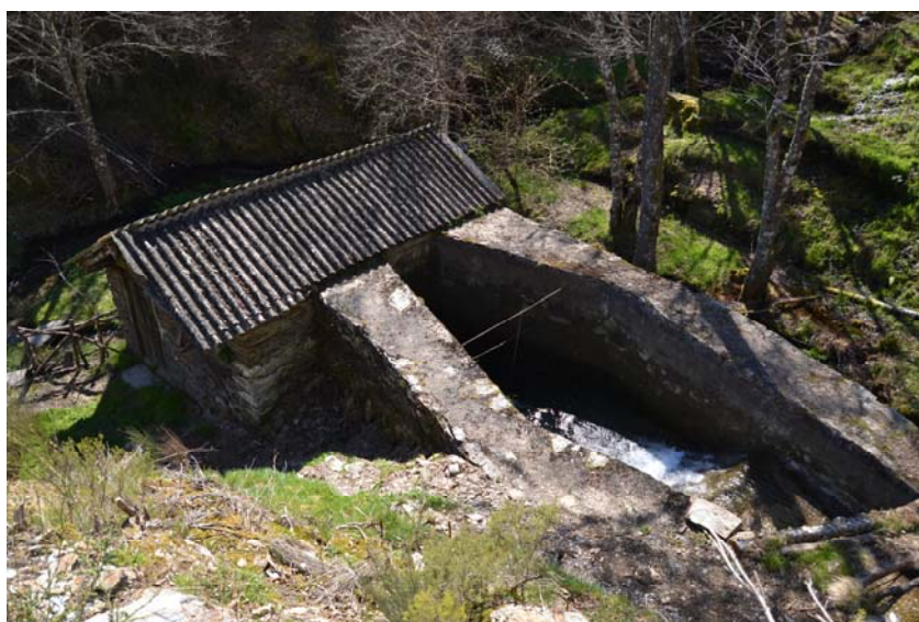
"Muíño de Tucende" na parroquia de Quintá (Becerreá, Lugo), co canal de entrada da auga e o depósito ben visible
